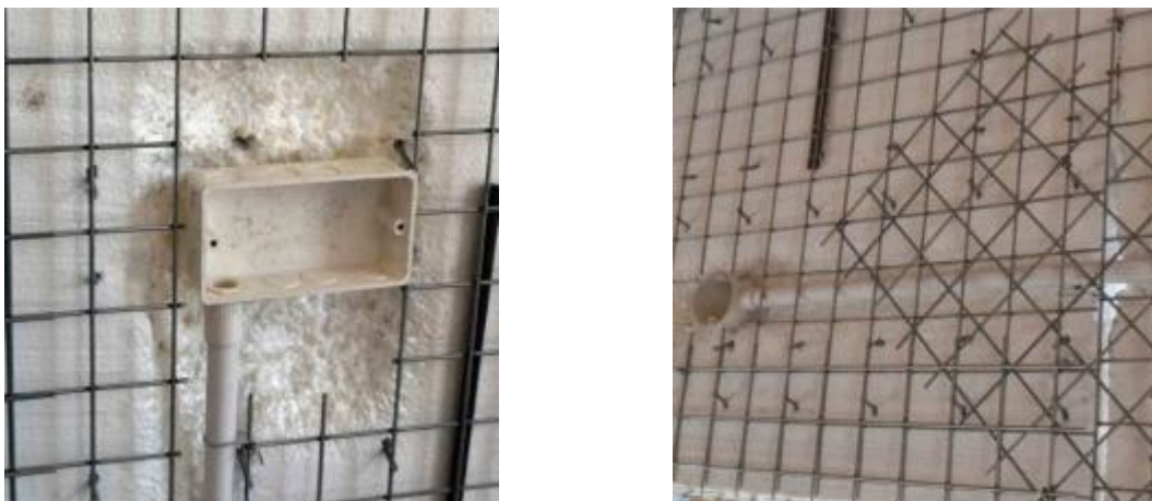
Fig. 8. Electric conduits provisions [15]
